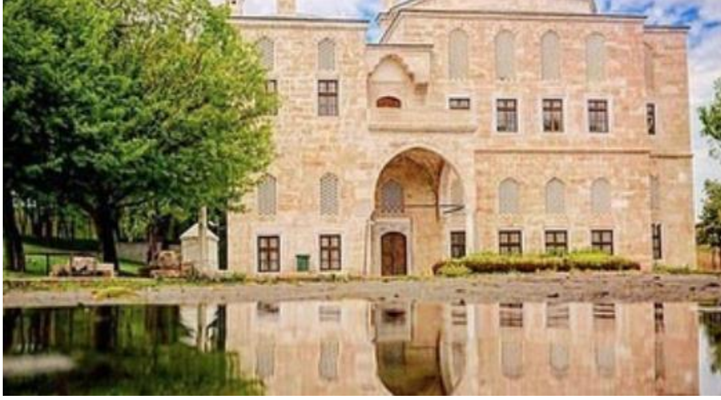
Otağ-ı Hümayun- Davutpaşa Yerleşkesi
