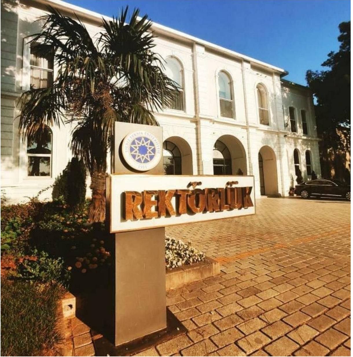
Rektörlük Binası, Davutpaşa Yerleşkesi
